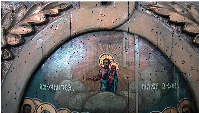
伊茲瓦雷爾村的治癒教堂（Healing Church），一幅被昆蟲寄生的木質聖幛，於 20 世紀春天在當地藝術修復者進行修復工作之前，先用加馬射線進行輻射照射。（圖片來源：C. Ponta / Horia Hulubei 國家物理與核子工程研究所）
