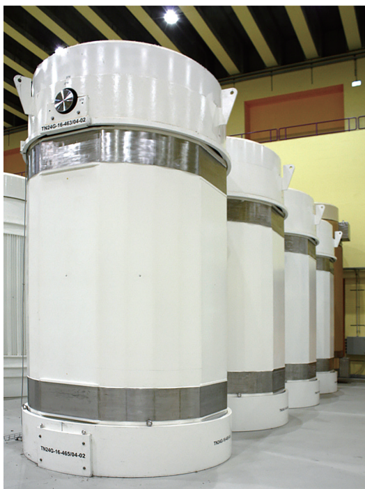
瑞士集中式中期貯存設施內所採用的用過核子燃料貯存護箱 (圖片來源: ZWILAG)
