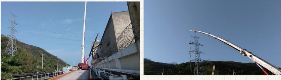
左圖：拆除鐵塔施工現場圖·右圖：核一廠一號機鐵塔拆除施作圖(圖片來源：台電公司)
