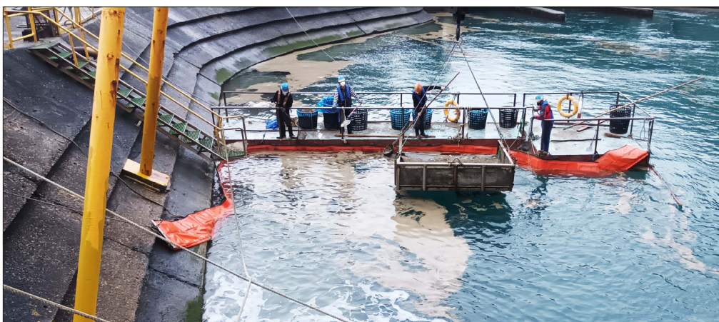
核二廠集水池、進水口火山浮石打撈作業。
