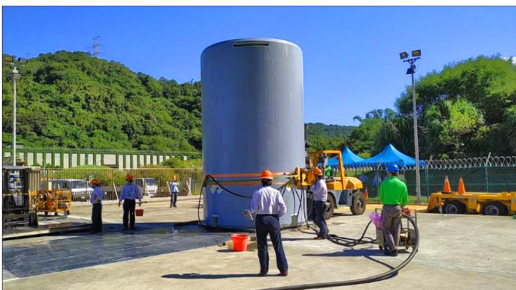
混凝土護箱移動定位作業。
