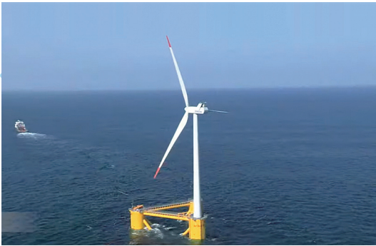
美國 Principle Power 公司的全尺寸浮體式離岸風力發電原型機 (WindFloat 1) · 該計畫於 2011 年安裝於葡萄牙維亞納堡 (Viana do Castelo) 近海 · 配備 0.2 萬瓩風力渦輪機。(圖片來源: Principle Power)
