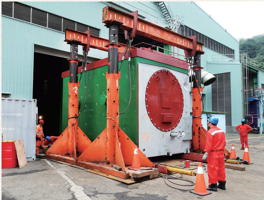
發電機定子以門式吊車移出氣渦輪機廠房，運往核二廠作為備品。(圖片來源：台電)
