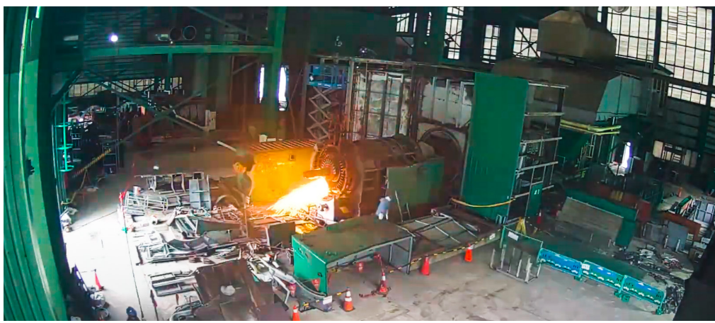
拆除氣渦輪機排氣煙道水平段。
