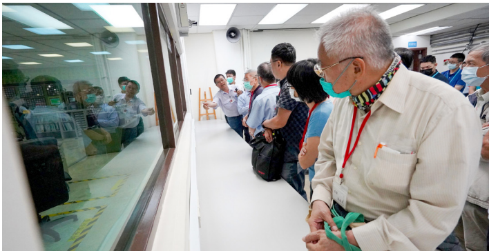
現勘一號機主控制室。
